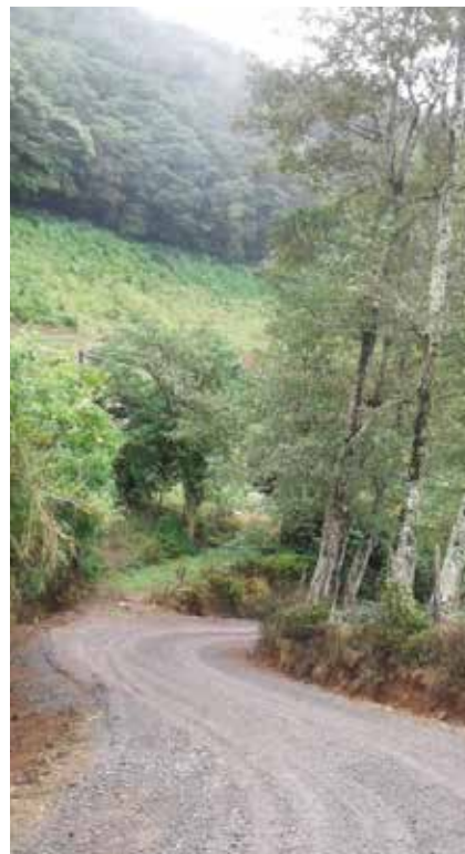
Intervención de calle Patio de Agua.
