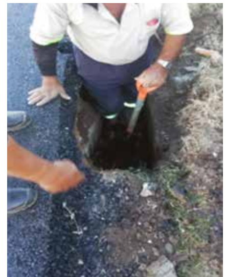
Limpieza de Cajas de Registro.
