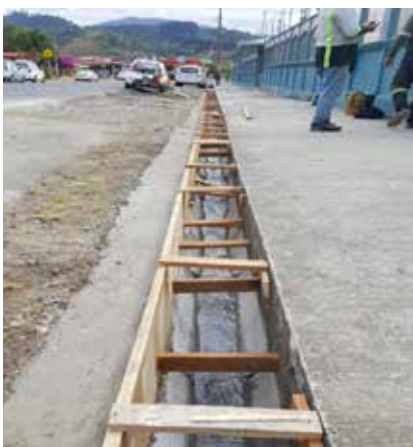
Colocación de cunetas.
