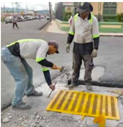
Colocación de parrillas en Tejar.
