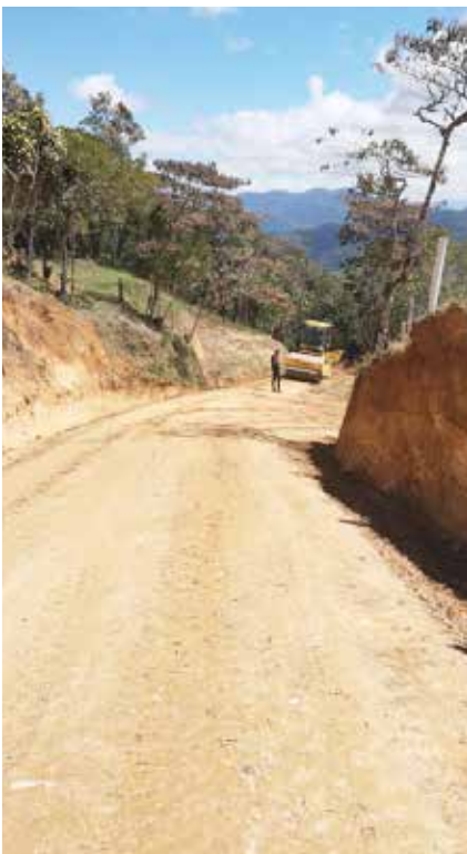
Intervención de calle Palo Verde.
